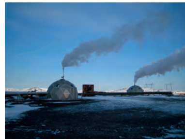
Fot. 25.11. Jeszcze więcej energii geotermalnej na Islandii Fot. Ward
