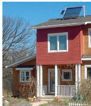
Fot. 30.2. Kolektor słoneczny podgrzewający wodę pewnej rodzinie z Michigan. Pompa kolektora jest zasilana niewielkim modulem fotowoltaicznym umieszczonym po lewej.
