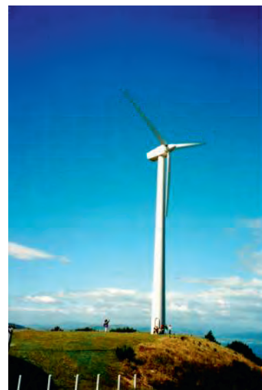
Fot. B.3. Wiatrak Brooklyn powyżej Wellington w Nowej Zelandii, z ludźmi u podnóża dla pokazania skali. W wietrzne dni wiatrak produkuje 60 \text{ kW} ( 1400 \text{ kWh} dziennie).
