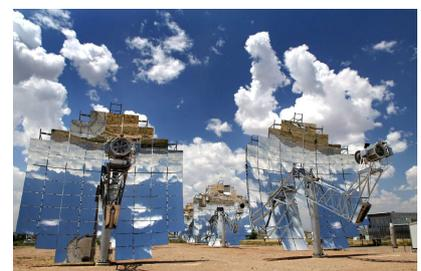
Abbildung 5. Dish-Stirling-Anlage. Dieser wunderschöne Konzentrador liefert eine Leistung pro Landfläche von 14 W/m<sup>2</sup>. Foto mit freundlicher Genehmigung von Stirling Energy Systems. [www.stirlingenergy.com](http://www.stirlingenergy.com)
