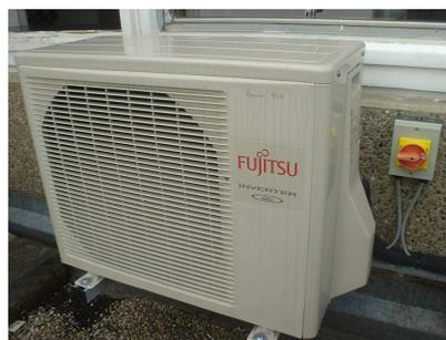
Abbildung 13. **Gut:** Die Teile einer Wärmepumpe für Drinnen und Draußen. Sie hat eine Leistungszahl von 4. Zum Größenvergleich ein Kugelschreiber neben dem im Haus angebrachten Teil. Eines dieser Fujitsu-Geräte liefert 3,6 kW Wärme, für die 0,845 kW Strom verbraucht werden. Es kann auch rückwärts betrieben werden: eine Kühlleistung von 2,6 kW, für die 0,655 kW Elektrizität benötigt werden.
