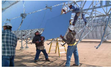
Рис. 8. Будівництво сонячної електростанції "Анадасол" потужністю у 100 мегават в Іспанії. Надлишкова термальна енергія, що генерується станцією протягом дня, зберігатиметься у величезних ємностях із розчином солі. За рахунок цього, забезпечуватиметься рівномірна подача струму до електромережі. Генеруюча потужність в розрахунку на одиницю площі становитиме 10 ват на метр квадратний. Фото люб'язно надані компанією "IEA SolarPCES"
