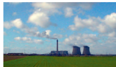
Rys. 21.7. Eggborough. Tu nie ma elektrociepłowni wykorzystujących powstające przy produkcji prądu ciepło.
