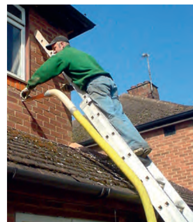
Fot. 21.5. Ocieplanie budynku
